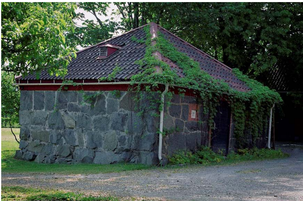
Fruktkällaren (foto: Hanna Schill, byggnadsantikvarie)
